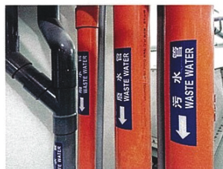
下水道工程 Sewer Engineering
