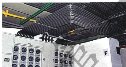
電導管工程 Electrical engineering
