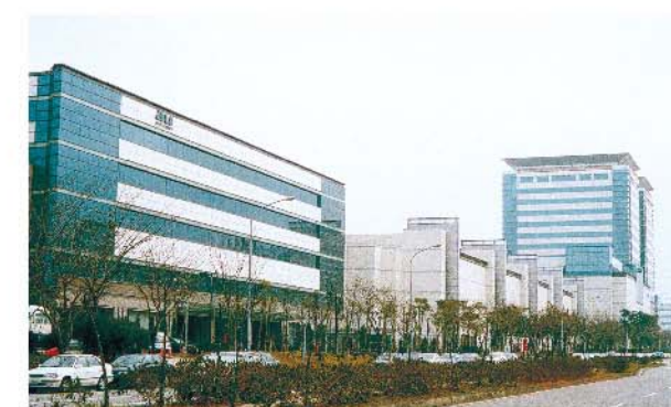
現代化高科技廠房
